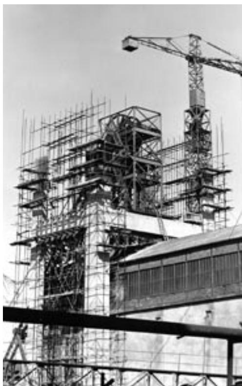
Construction de l'enveloppe béton du chevalement de Bois 2 (A.D. Maine-et-Loire).
